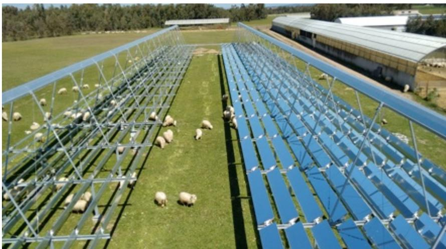
Capteur Fresnel produisant de la vapeur pour une laiterie en Sardaigne - cspfolar.com
